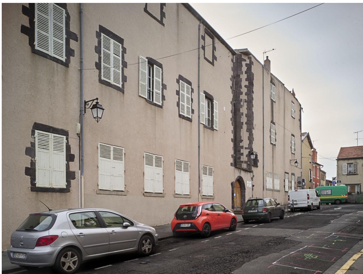
Elévation principale, depuis le nord
