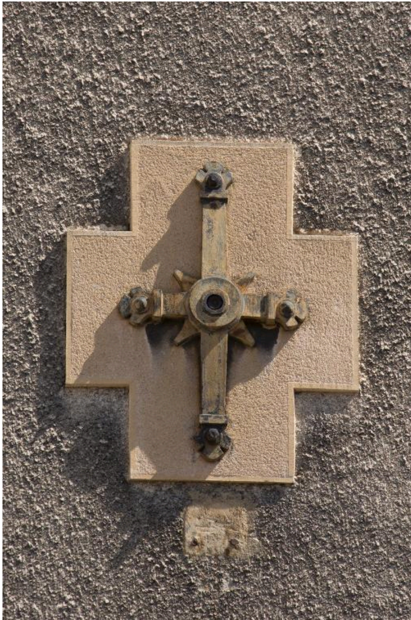
Bâtiment G, façade orientale. Détail ornemental et technique
