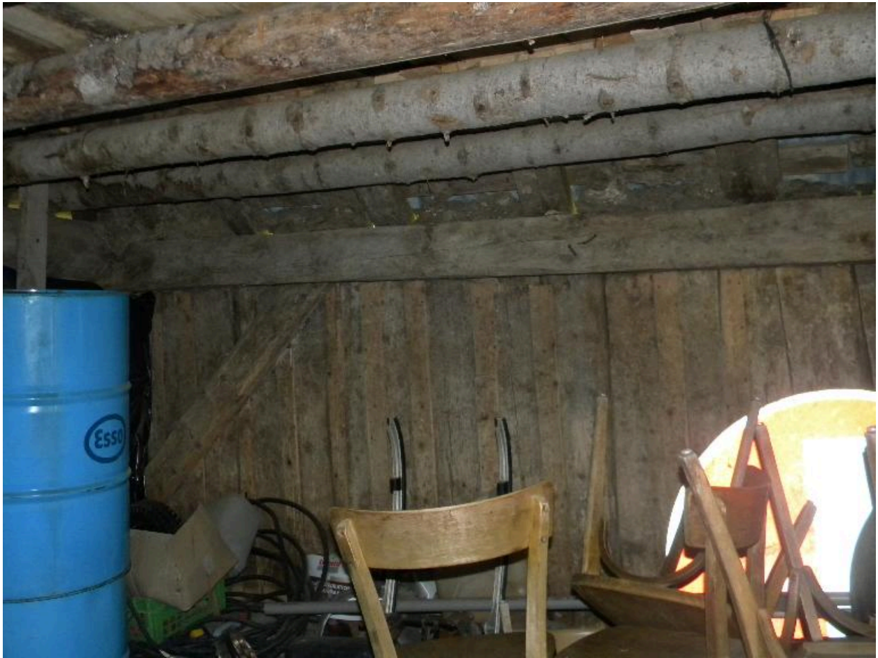
Vue intérieur de la jonction toiture bardage
