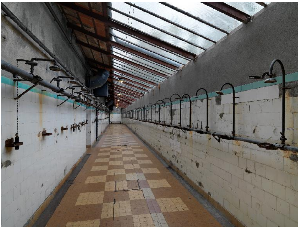
Couloir des douches
