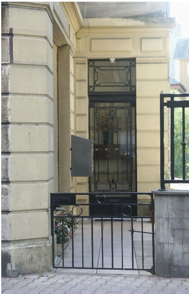
Détail du corps de porche
