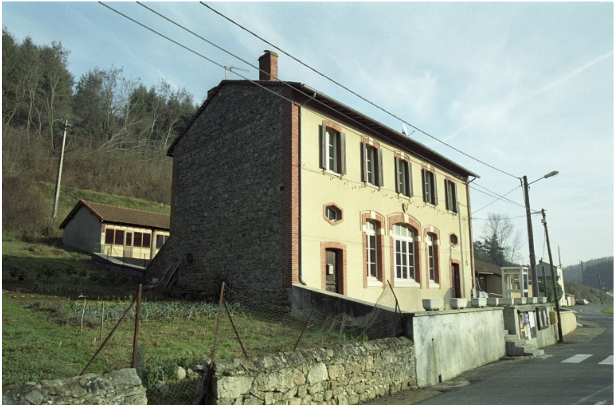
Vue d'ensemble de la mairie-école, au Périer (1987 A1 565).
