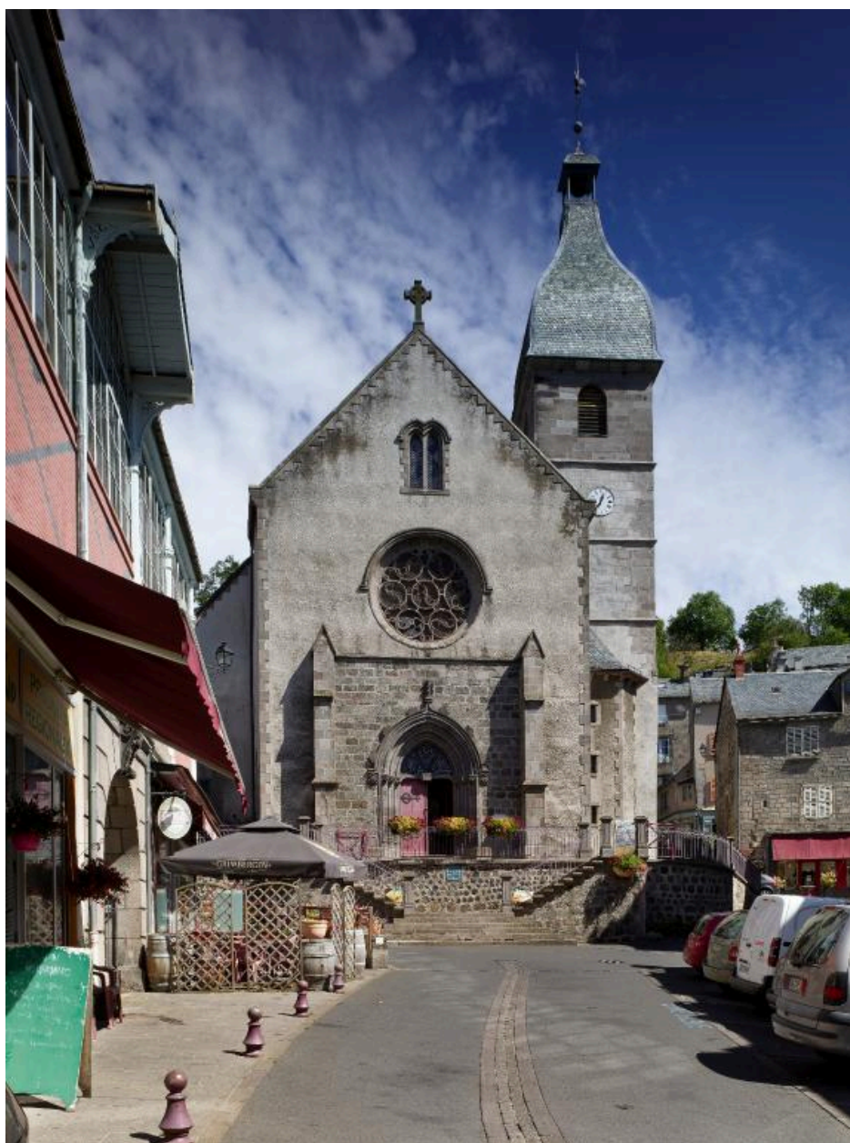
Vue de la façade occidentale
