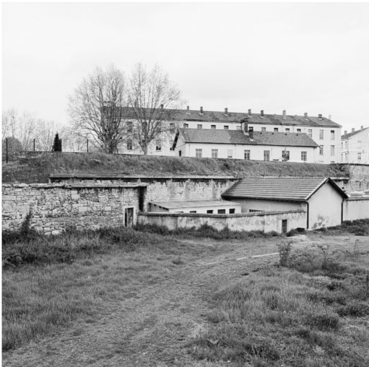
Front bastionné droit avec le bâtiment de tir
