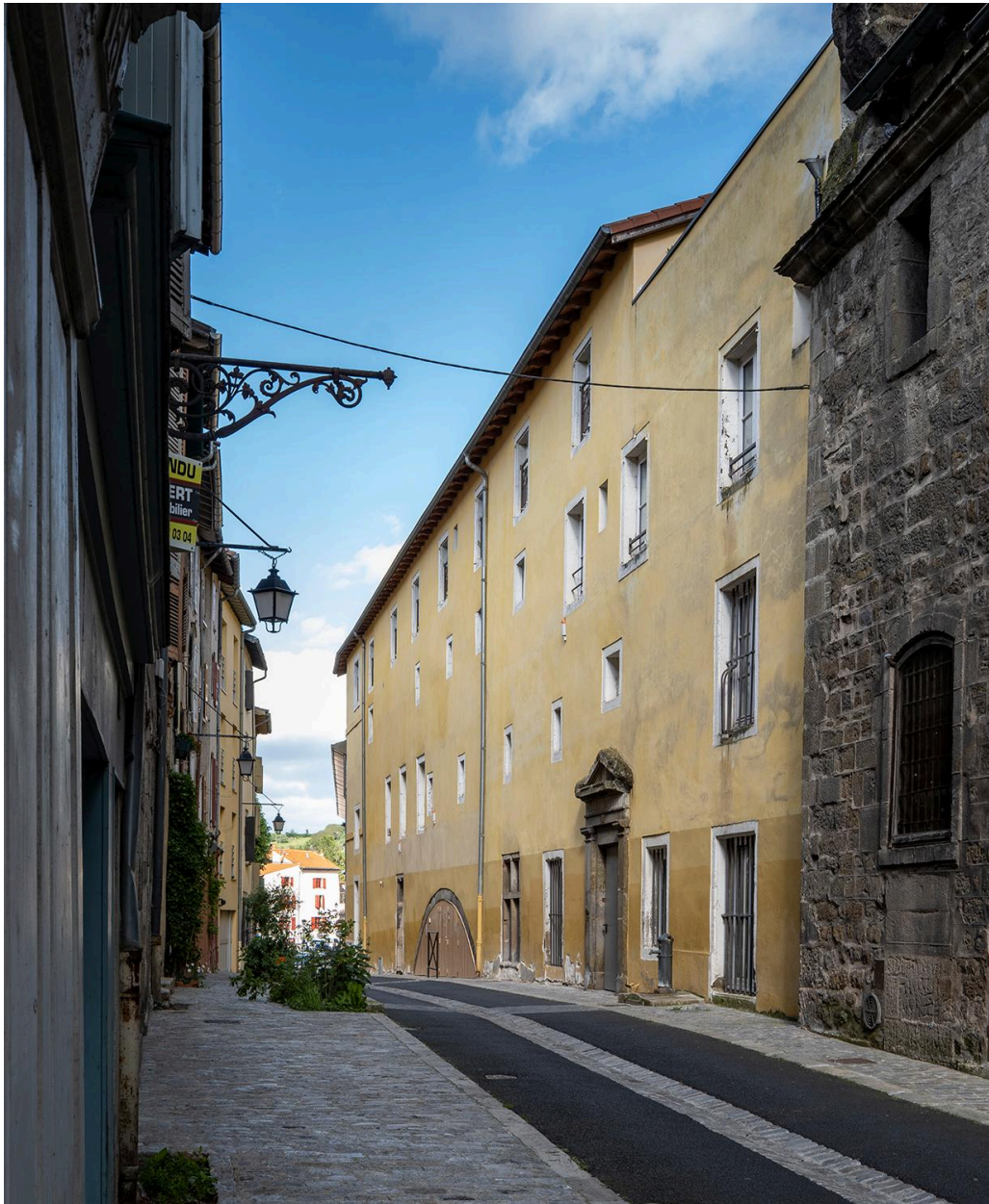
Bâtiment E, élévation sur rue depuis l'ouest en 2025
