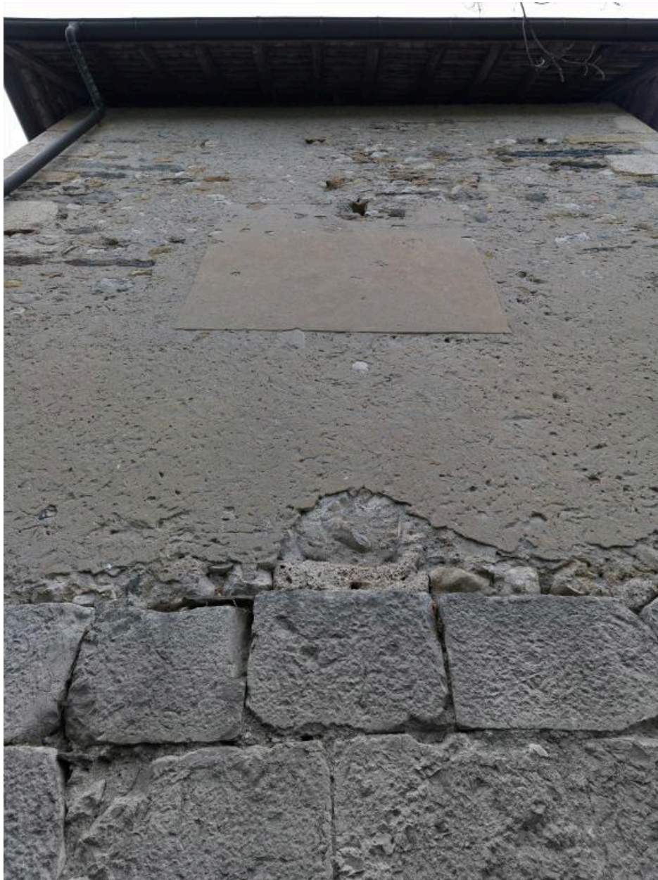
Détail de l'élévation du chevet.
