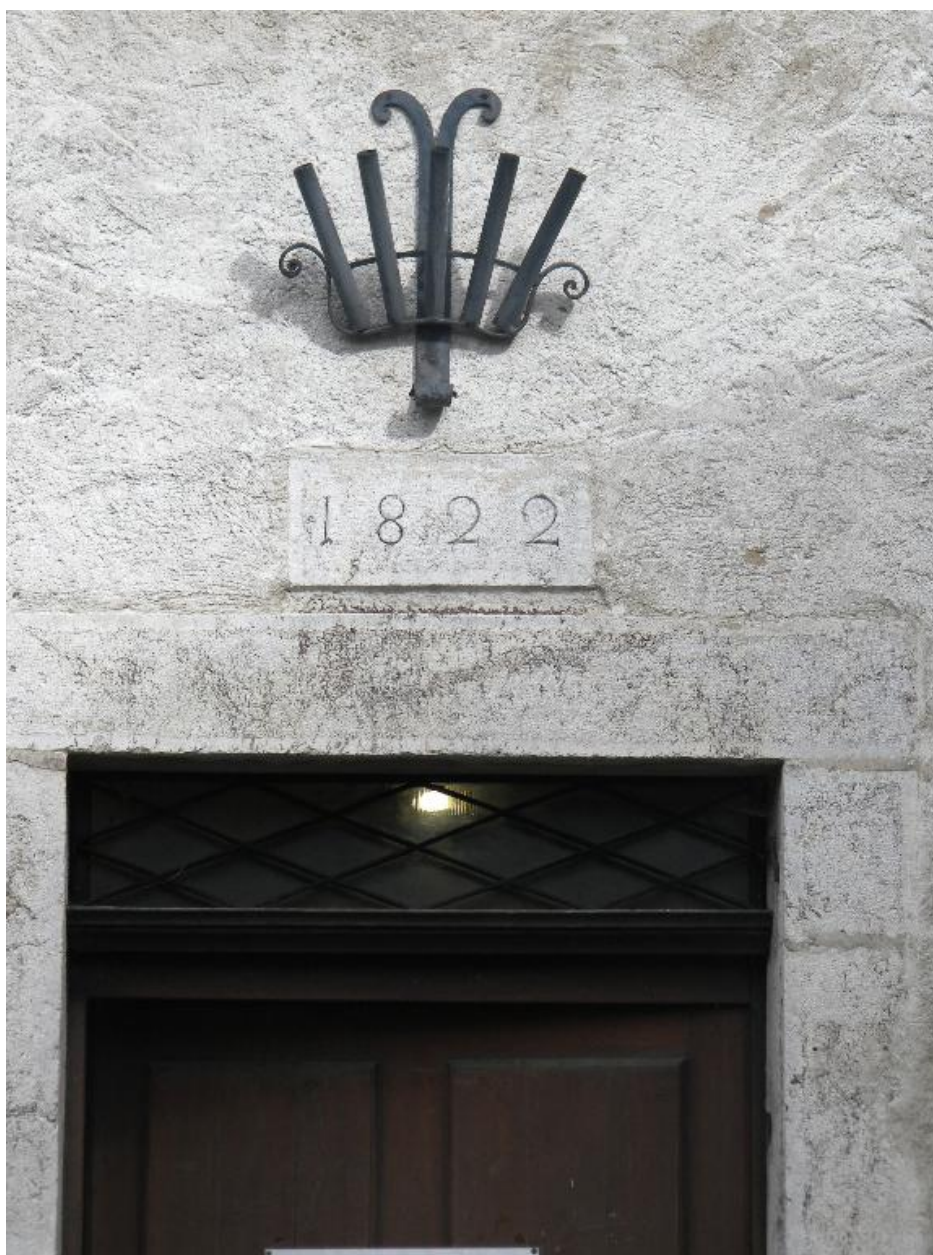
Détail du cartouche daté au-dessus du linteau de porte.
