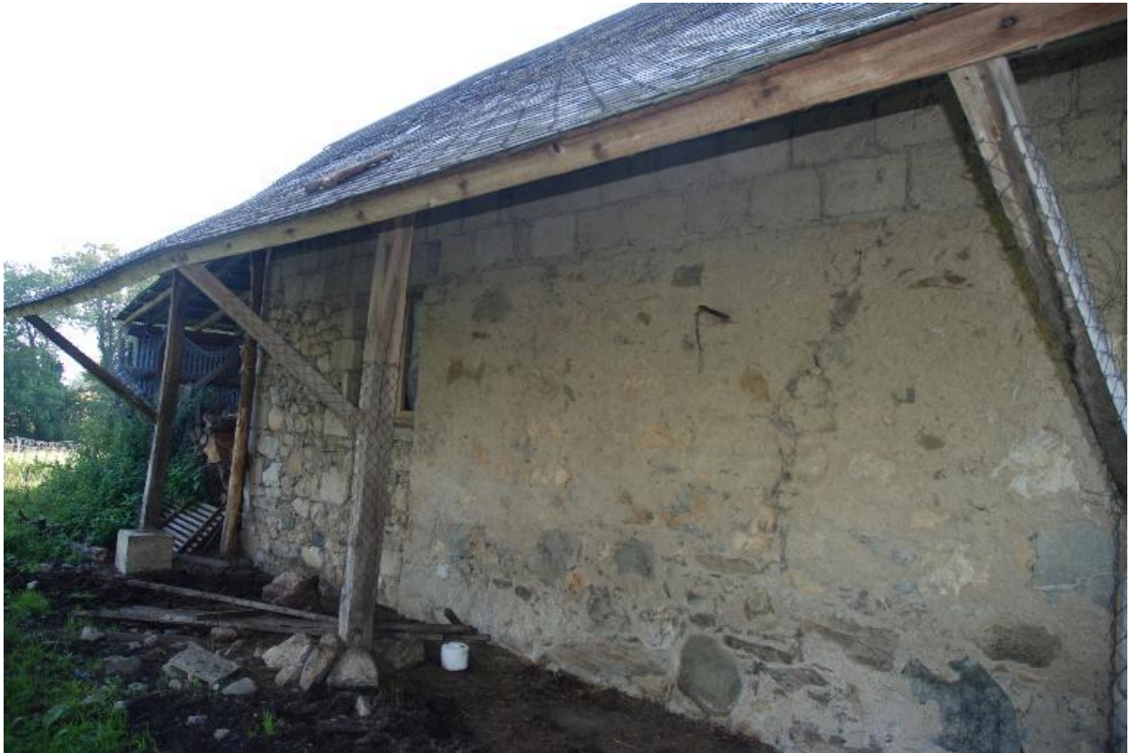
Vue du four à pain ; mur exhaussé en parpain de béton plein.
