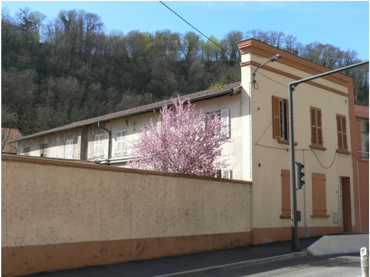
Façade principale sur rue
