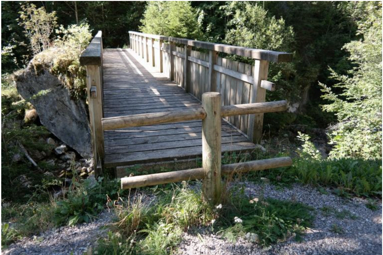
Passerelle de Porte, vue du tablier et des garde-corps
