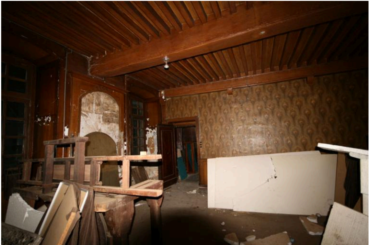
Salle du 1er étage de soubassement (salle -1.5 du plan schématique) - préservée lors des travaux de 2008 (photographie chercheur).
