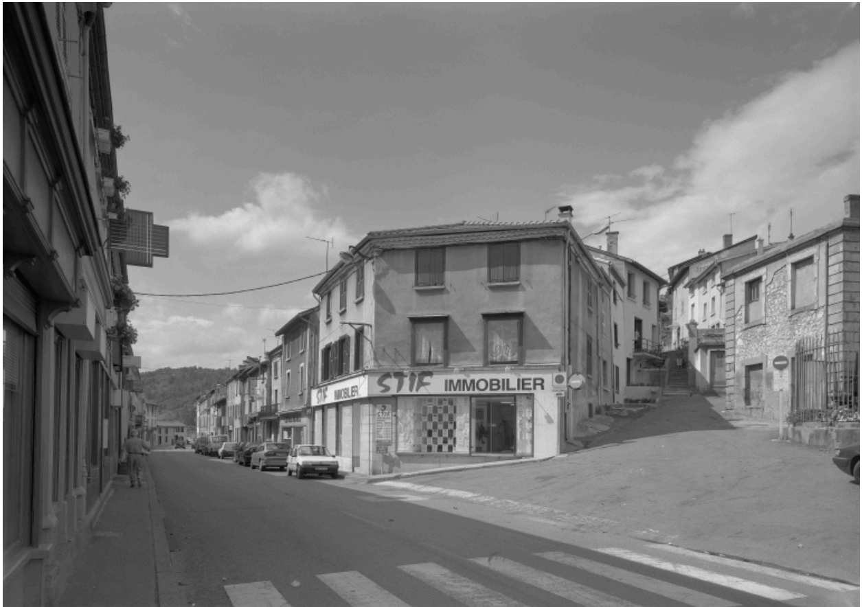
Vue de la rue de Clermont, à hauteur de l'entrée du château (n°39), du sud.
