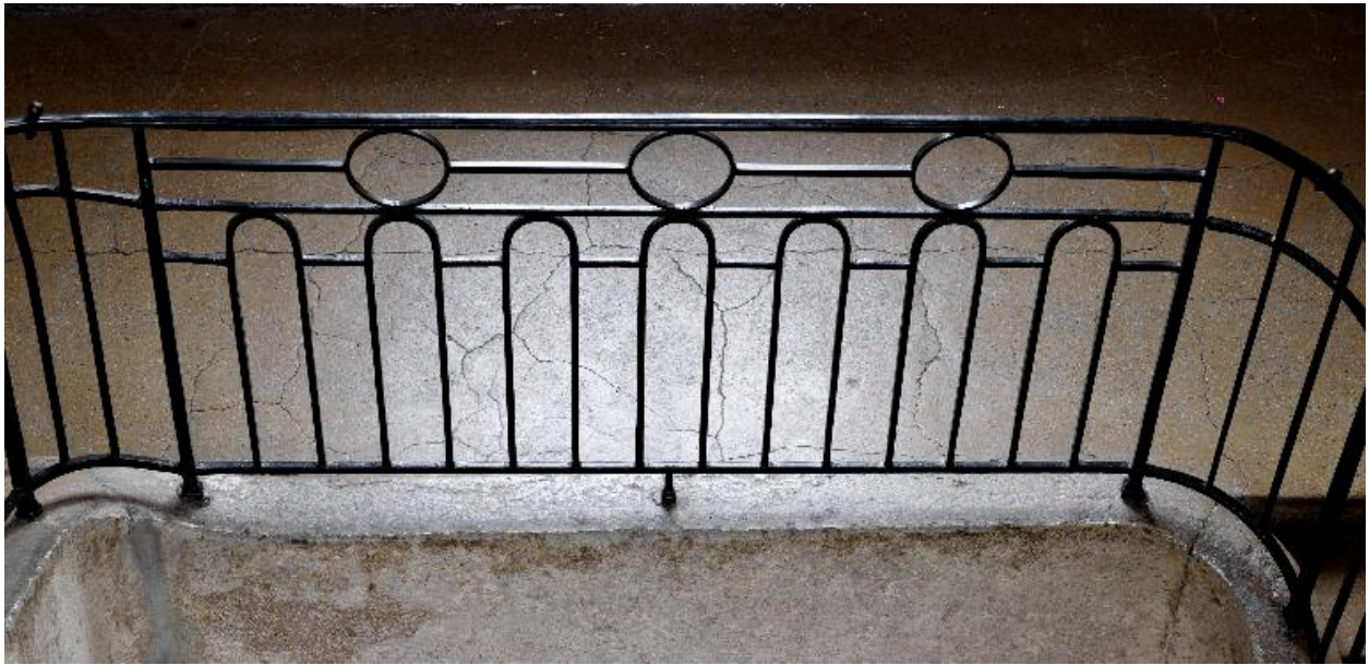
Escalier principal, garde-corps
