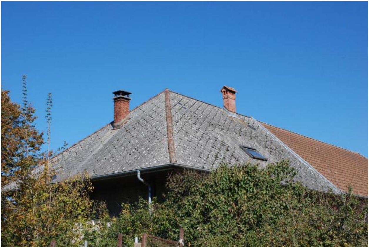
Vue partielle de la toiture du logis avec ses cheminées en brique
