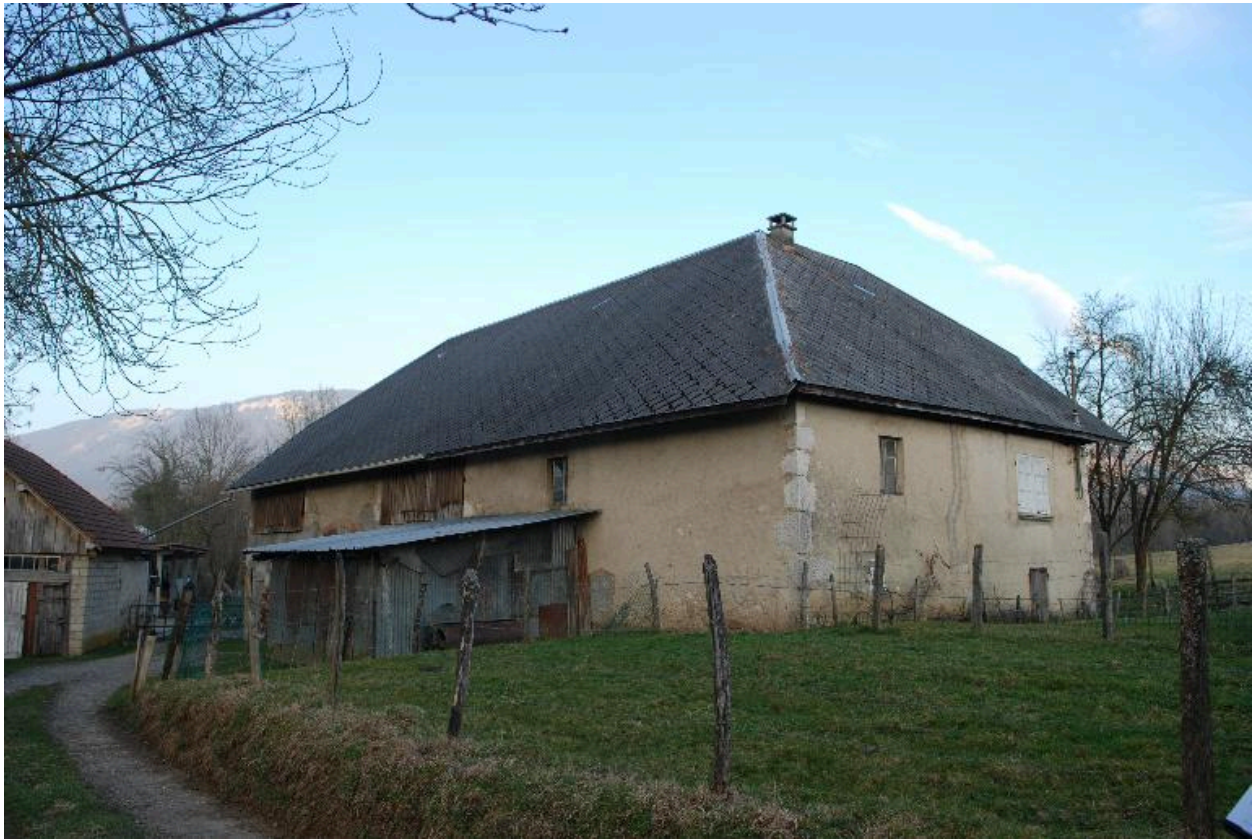
Vue d'ensemble de trois-quarts arrière droit.
