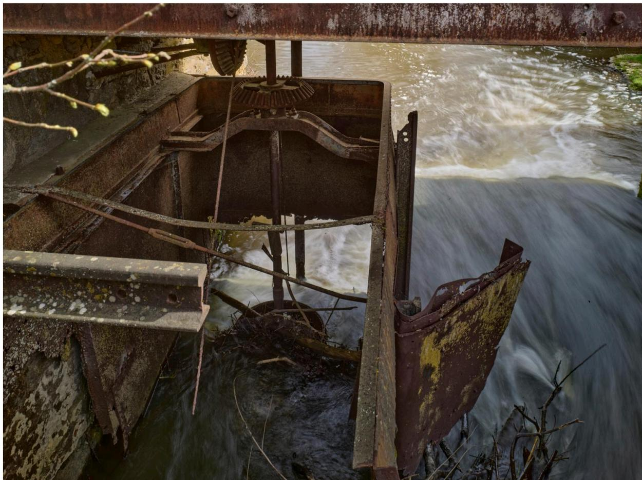
Détail de l'engrenage de la turbine métallique, extérieur.
