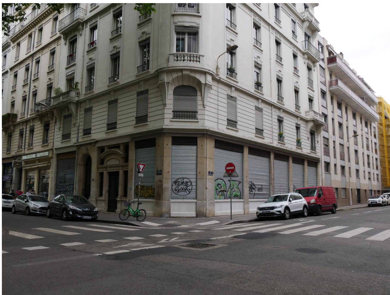
Vue d'ensemble rez-de-chaussée usine Bergès-Lyon
