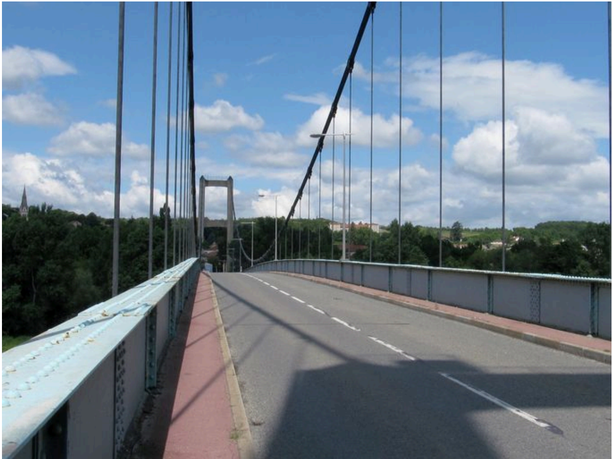
Vue partielle, de dessus, chaussée et parapet (depuis la rive gauche)
