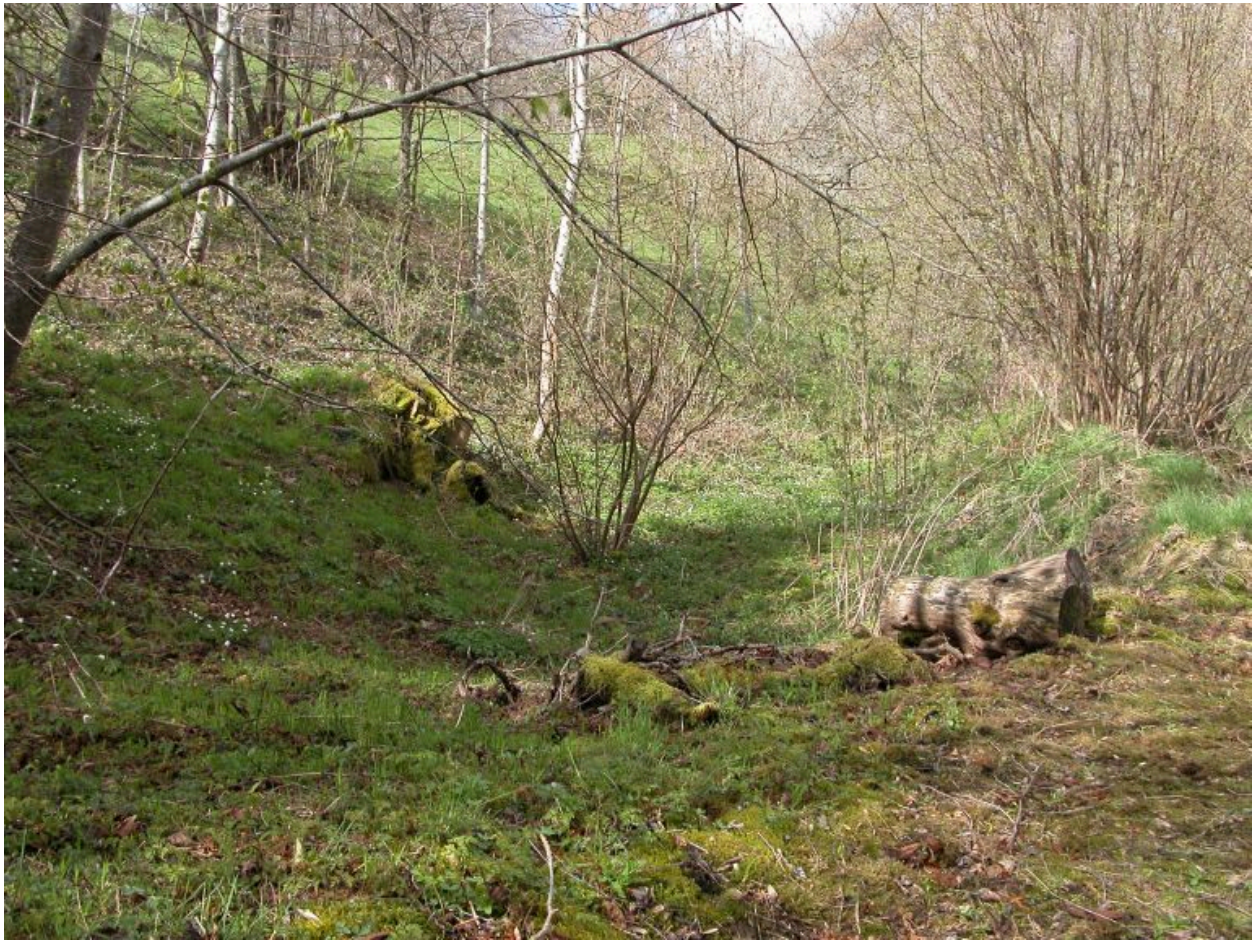
Vue d'ensemble de l'ancienne retenue d'eau alimentant le moulin.
