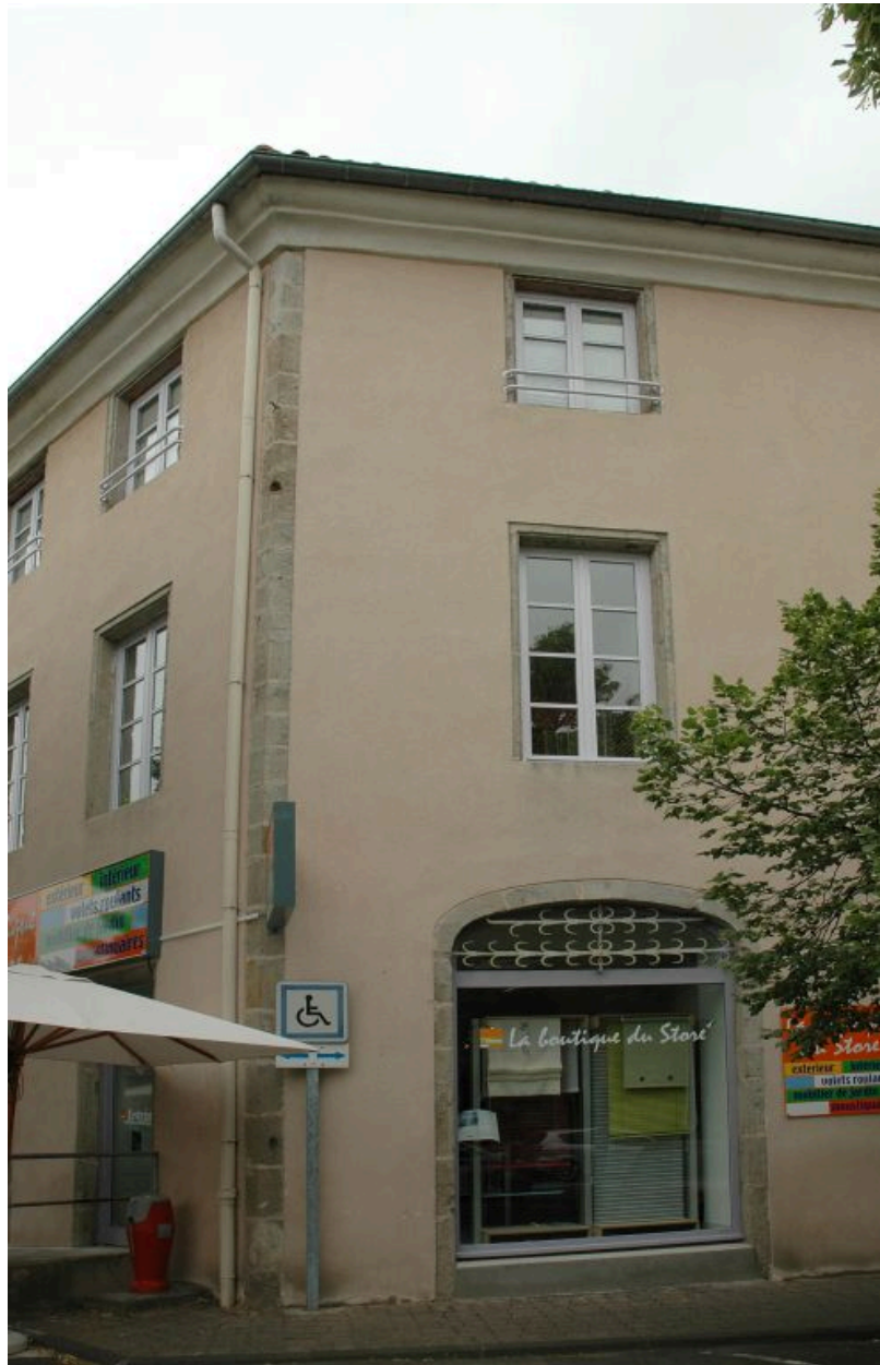
Vue partielle de l'immeuble : travées d'angle sur le boulevard.
