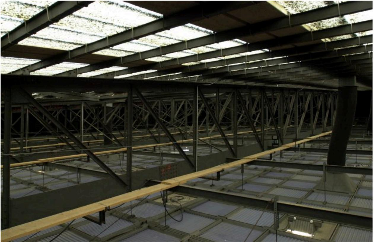
Détail d'une poutre porteuse de 72 m de portée
