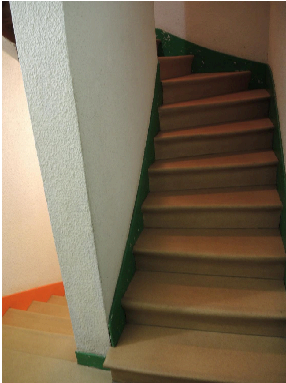
Vue des escaliers
