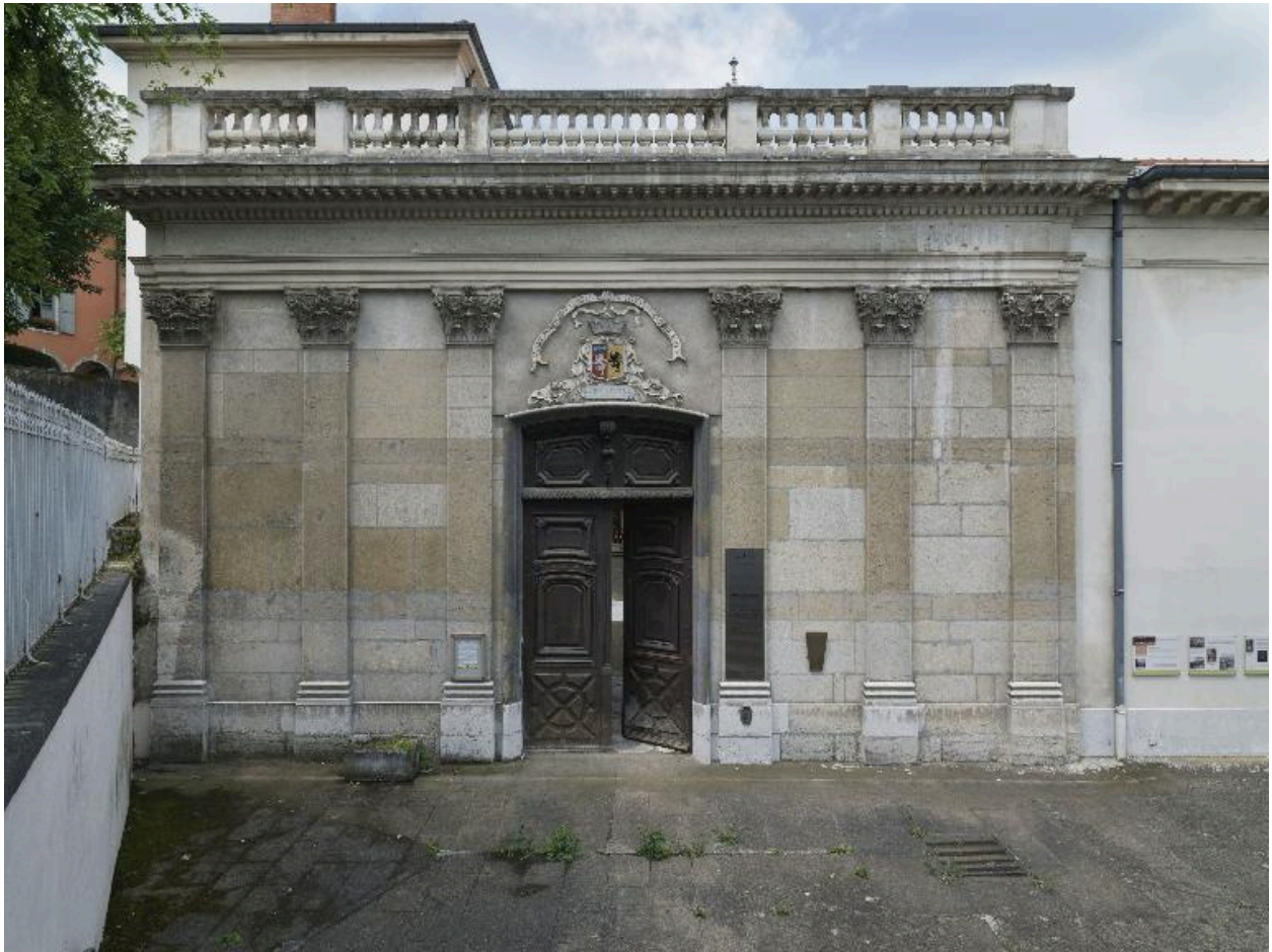
Vue générale de la façade est
