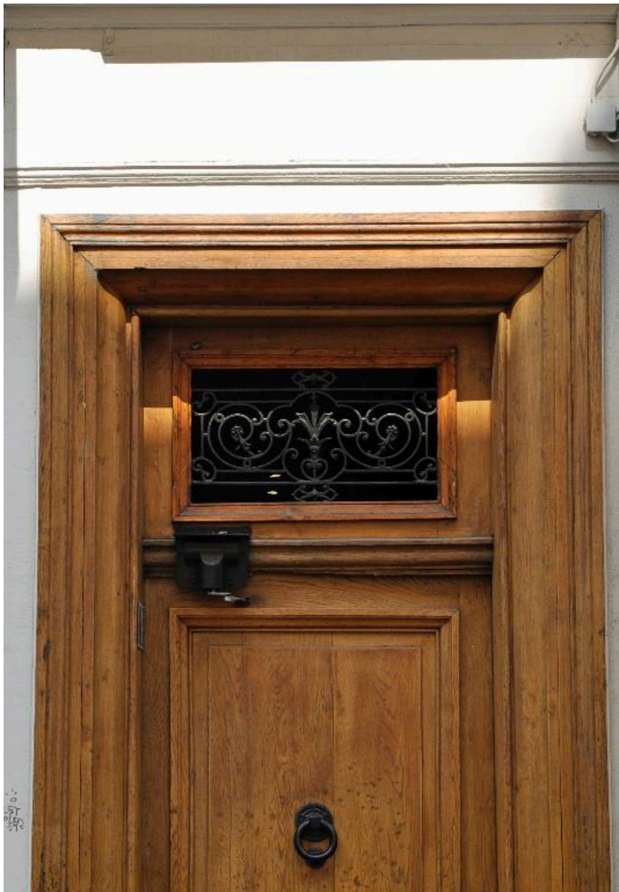
Détail de la porte : imposte en ferronnerie
