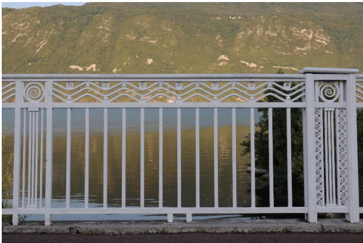
Détail des garde-corps
