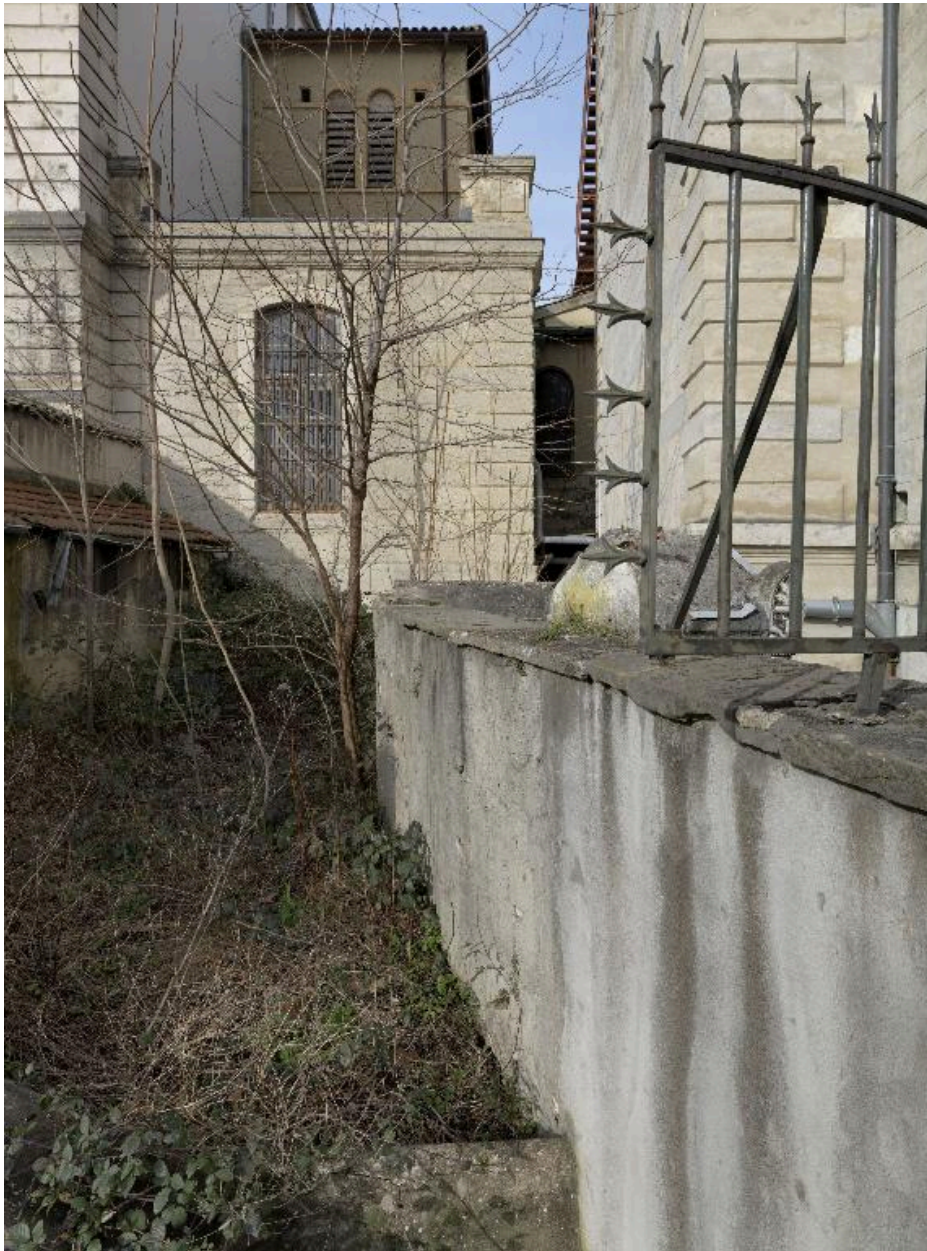
Prieuré, le jardin, délaissé dans la partie nord de la parcelle
