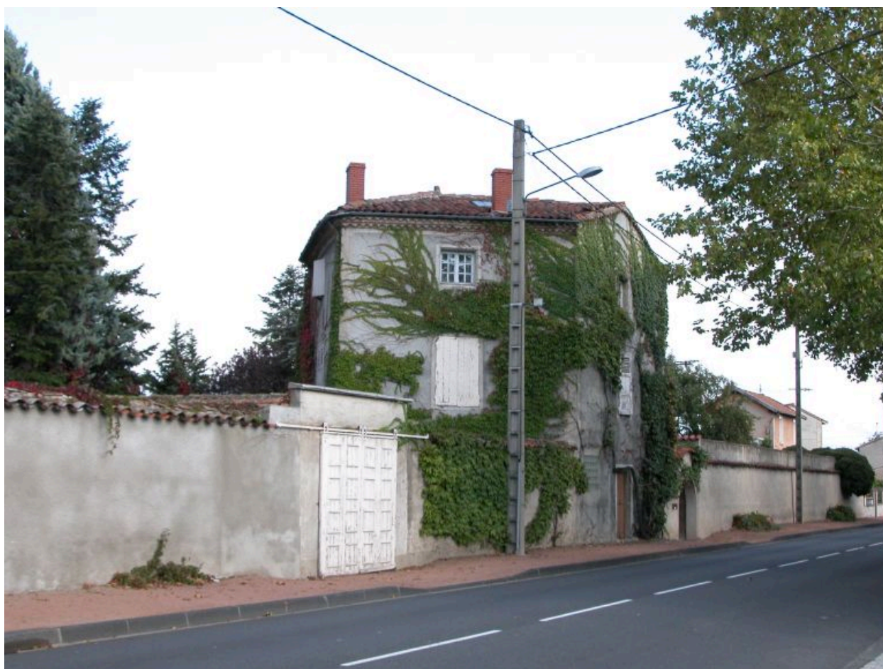
Cuvage transformé en habitation (?) (Montbrison, Moingt, les Purelles, 1986 AK 53).
