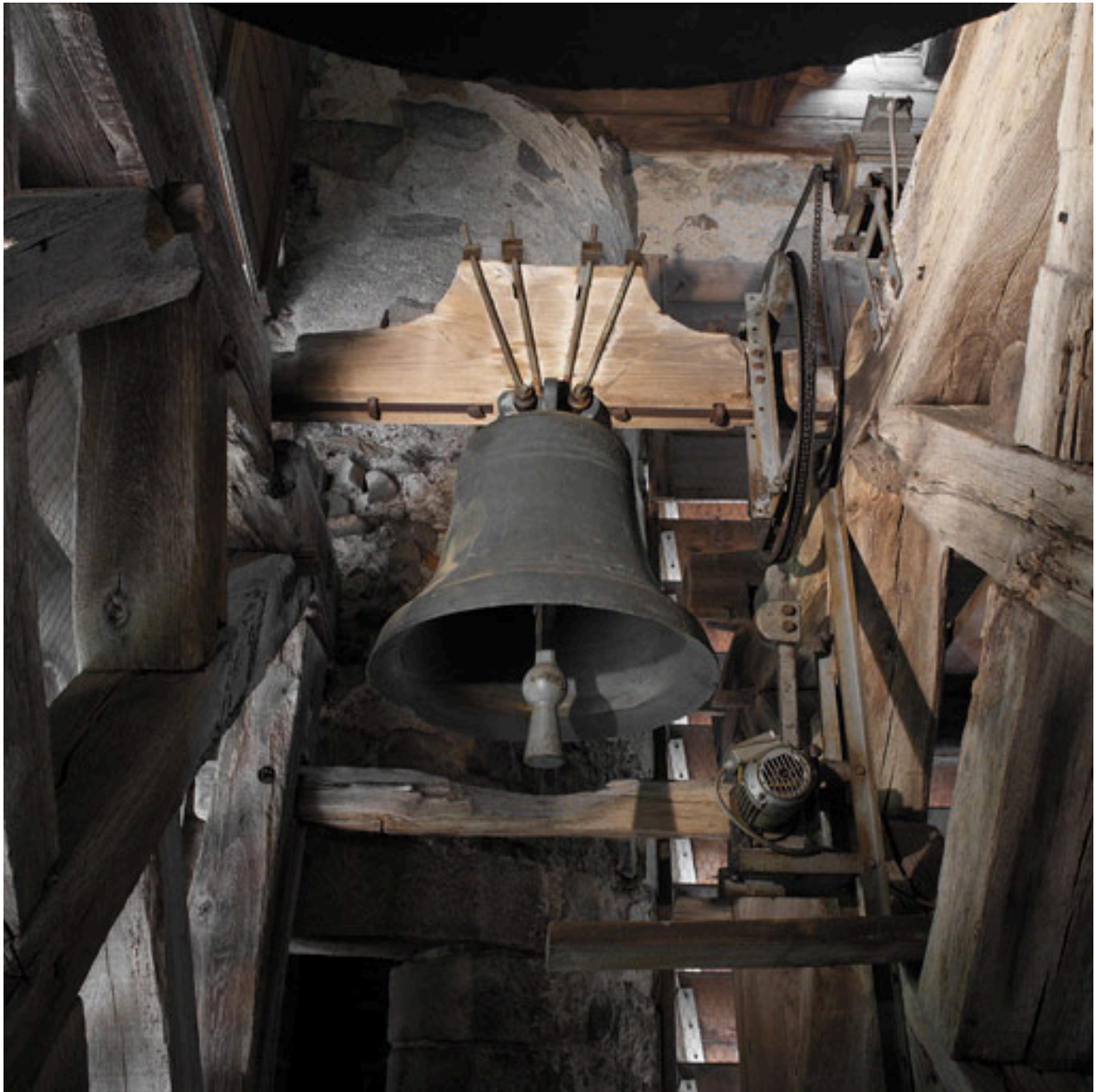
Vue générale de la cloche en place dans le clocher de l'église.
