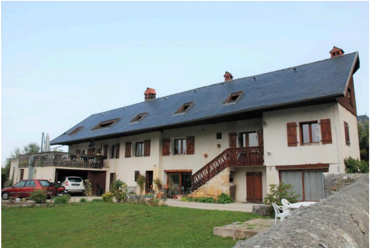
Viuz-Nord, C4 239 à 241, fermes, actuellement maisons. Vue d'ensemble du corps de bâtiment de trois-quarts avant droit.
