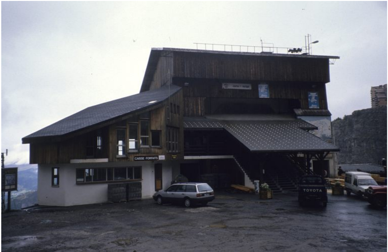
Elévation est. Photogr. 1989
