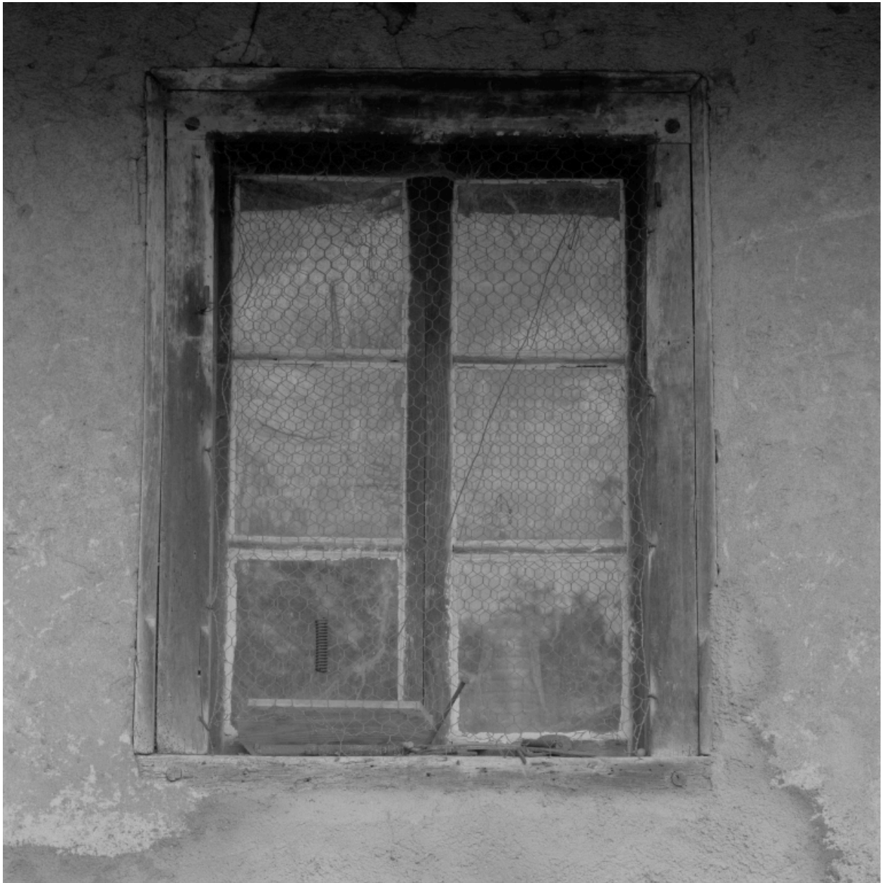
Détail de la baie de la cuisine du logis ancien.
