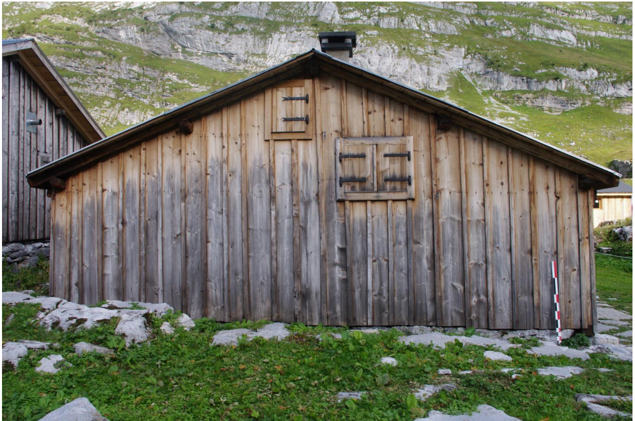
Vue du mur pignon ouest
