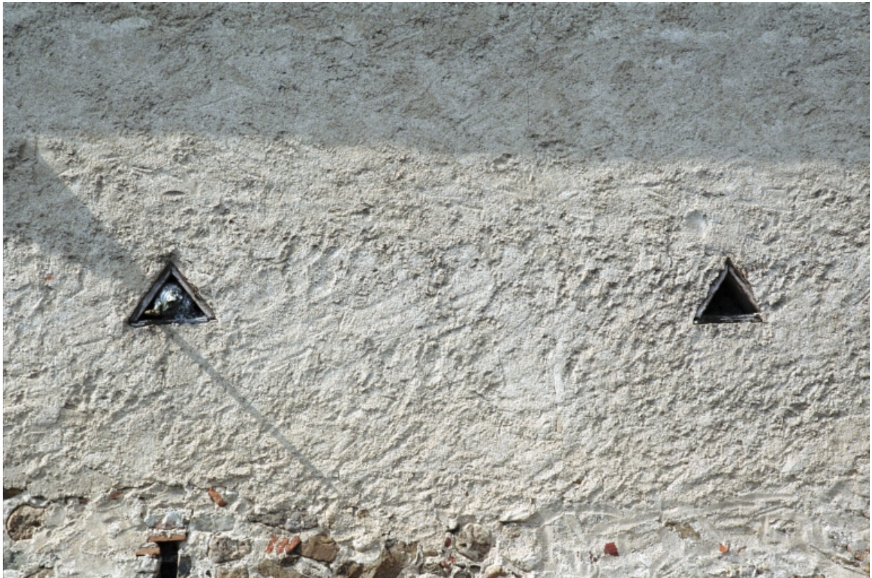
Montverdun, Meximieux, ferme (1986 A2 400). Détail des ouvertures dans le mur de clôture en pisé de la cour.
