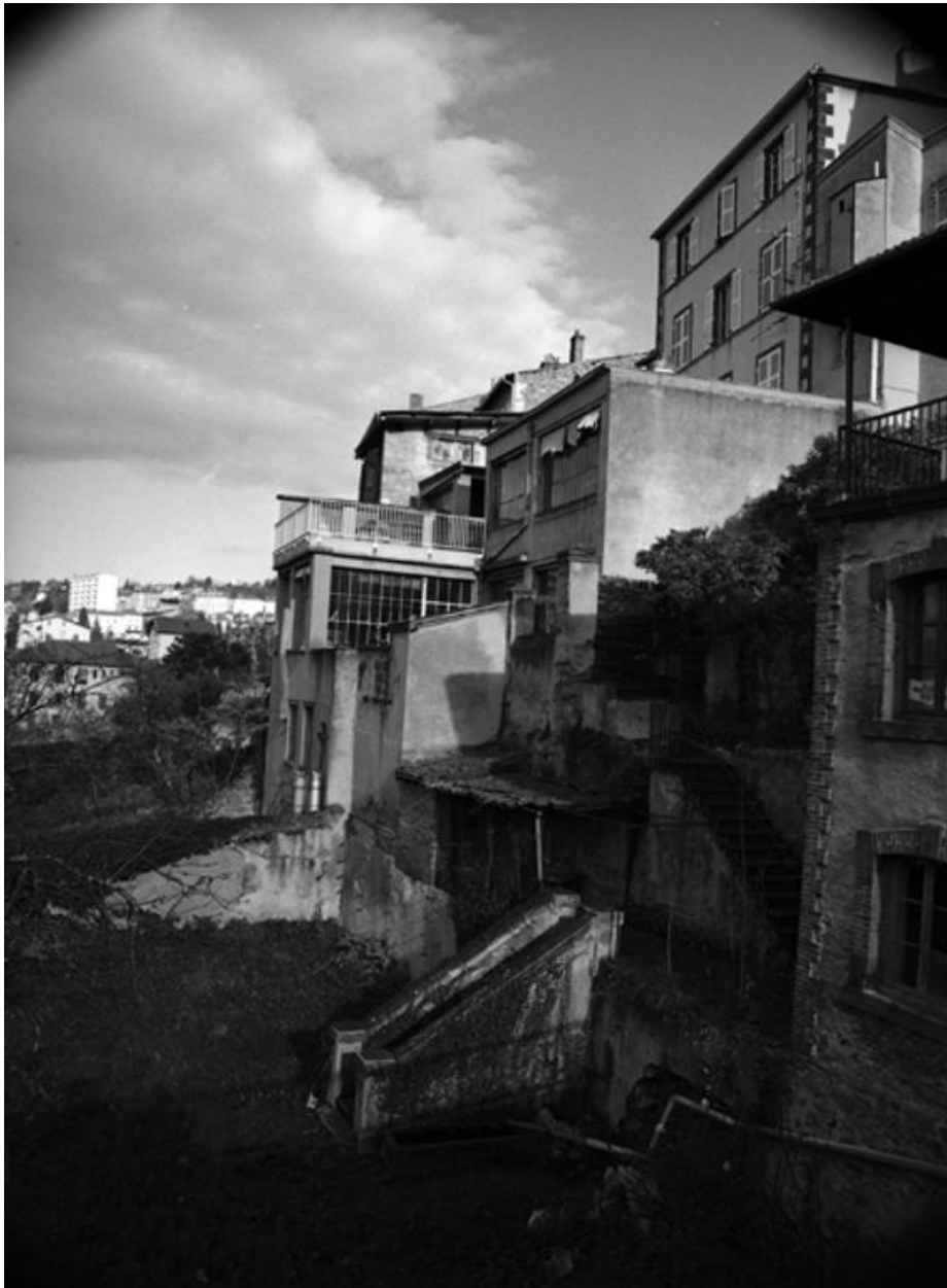
Les ateliers de la fabrique de tire-bouchons Cartailier Deluc, sur les élévations postérieures de la rue.
