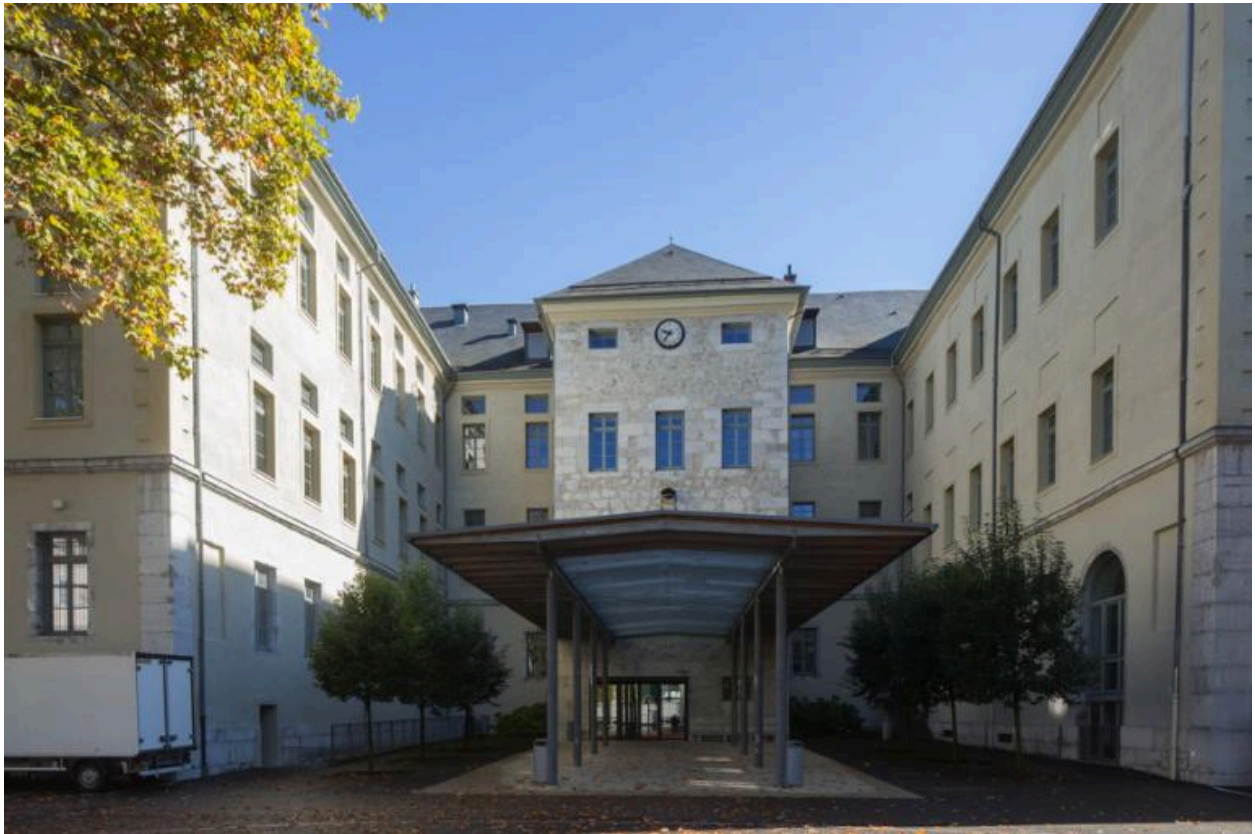
Cour intérieure, nouveau préau central.
