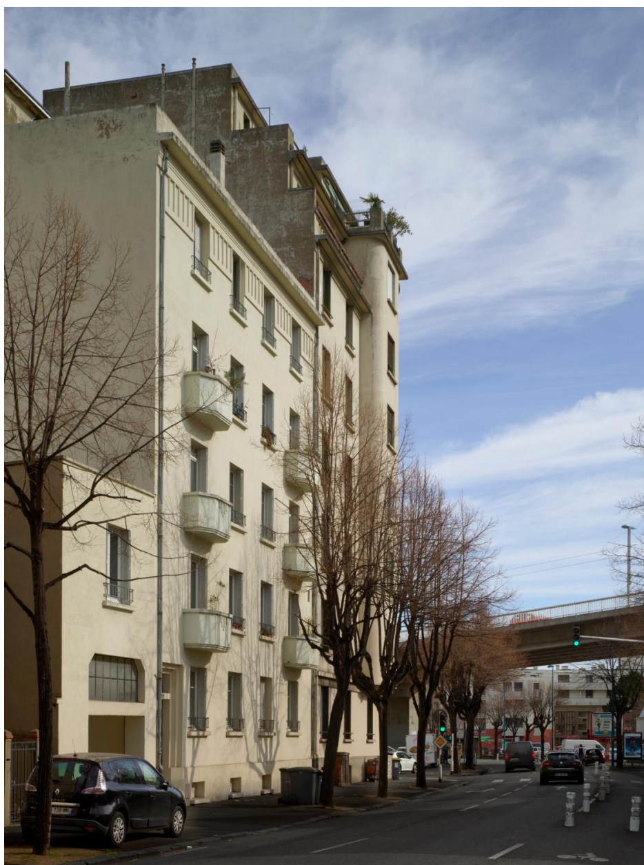
Façades sur le boulevard Cote-Blatin
