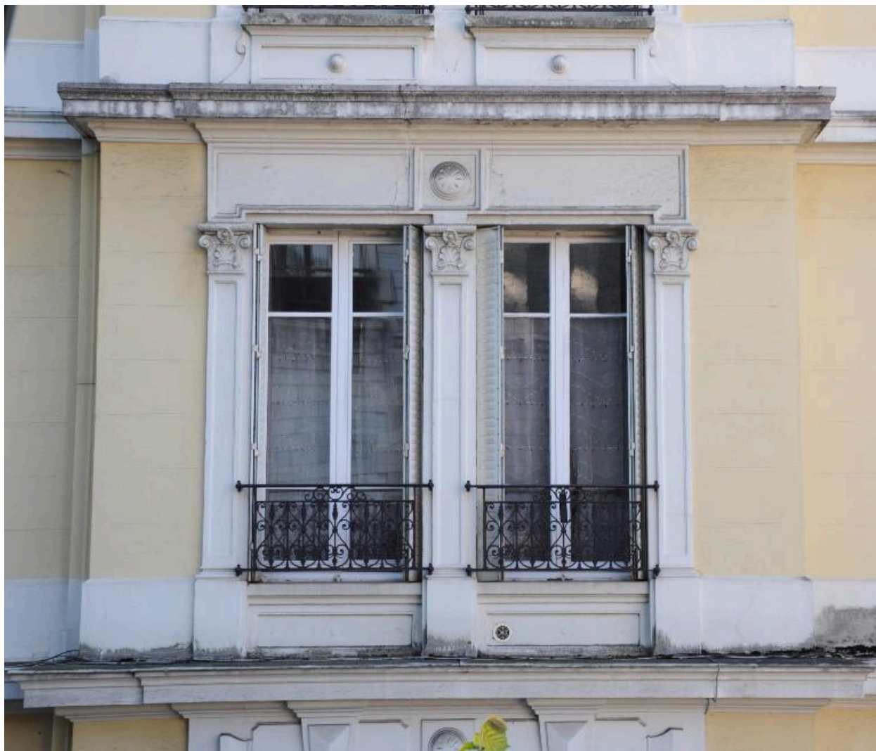
Baies jumelées sur la façade latérale gauche (façade nord)
