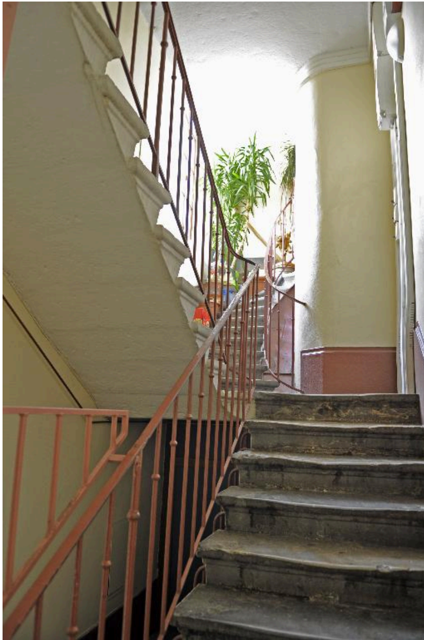
Vue intérieure de l'immeuble : le départ de l'escalier
