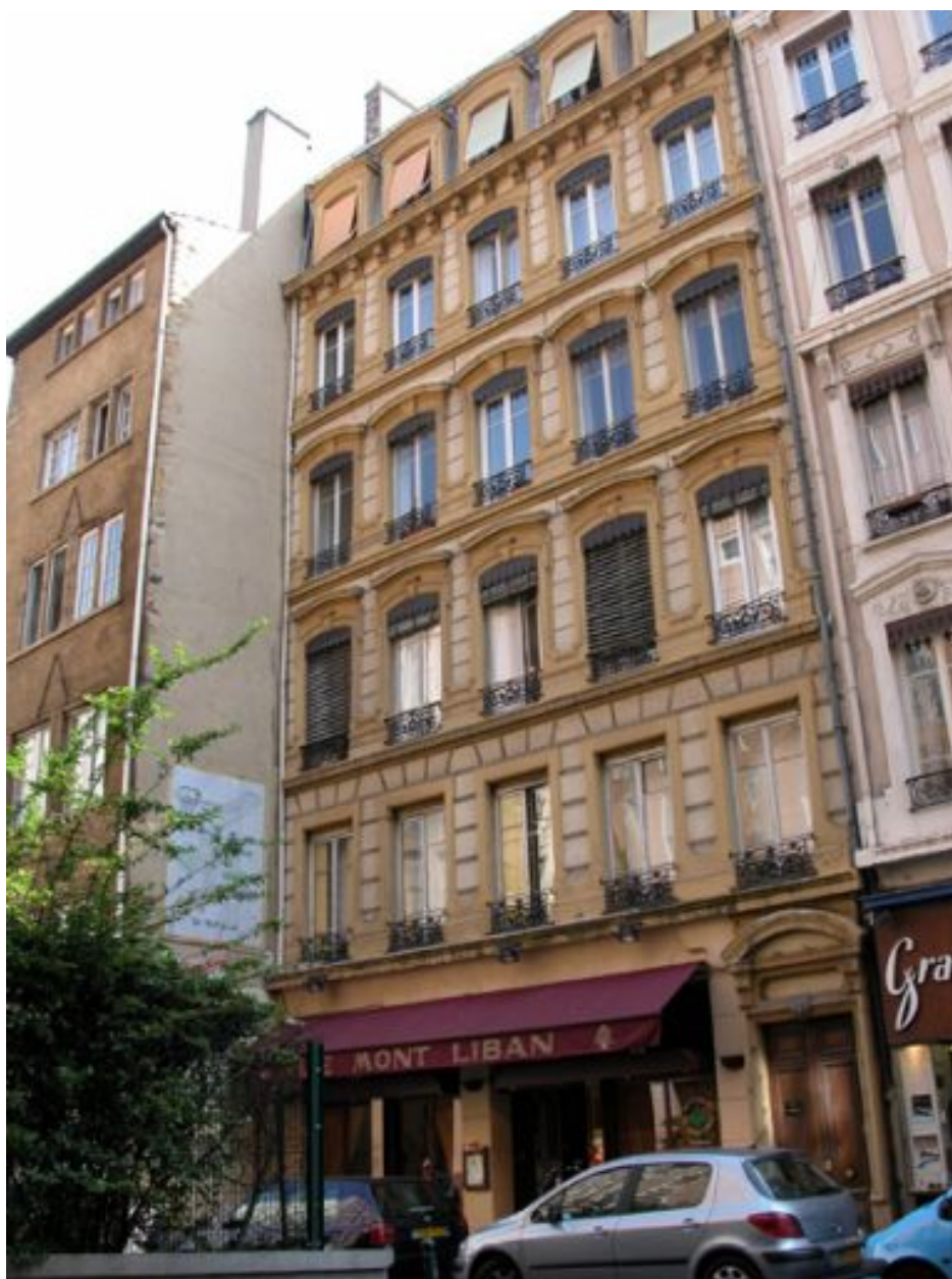
Façade principale rue Mercière, vue générale
