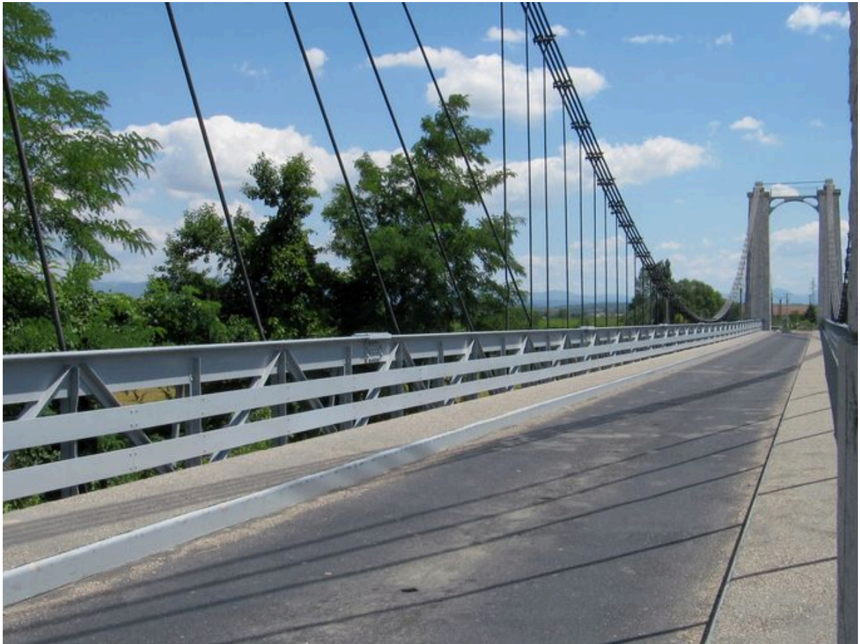
Chaussée (depuis la rive droite)
