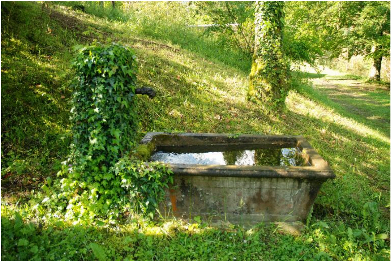
Vue de la fontaine-abreuvoir.
