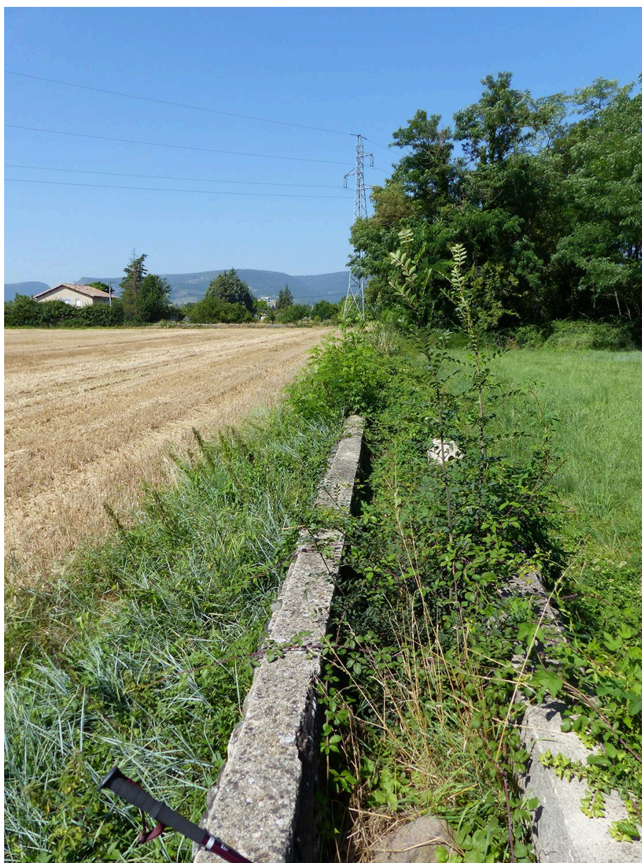
Aqueduc : vue du canal par en-dessus
