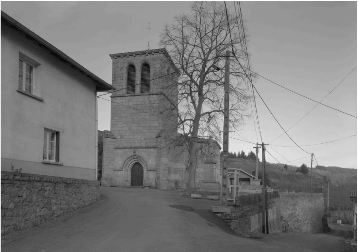
Vue générale de l'église depuis l'ouest.
