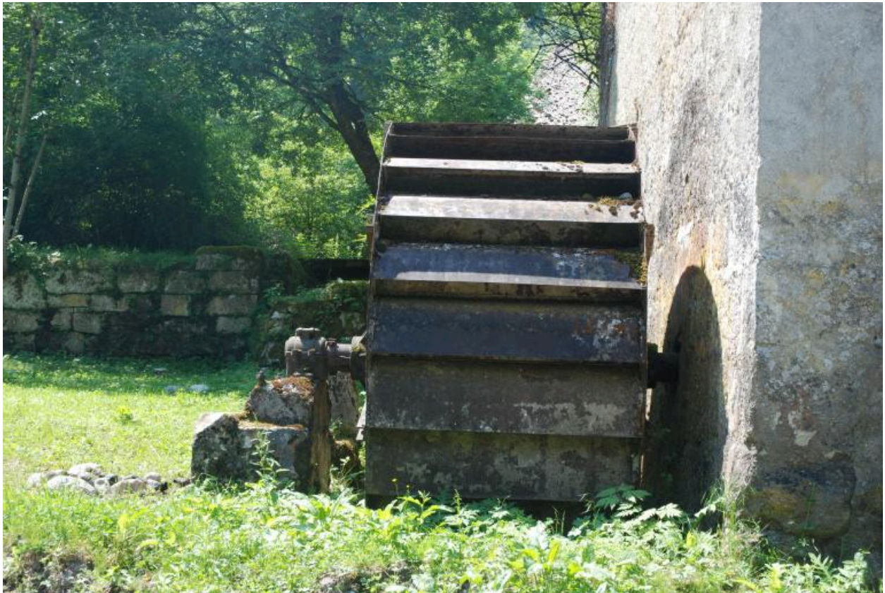
Vue du bâtiment principal, élévation est : détail de la roue.
