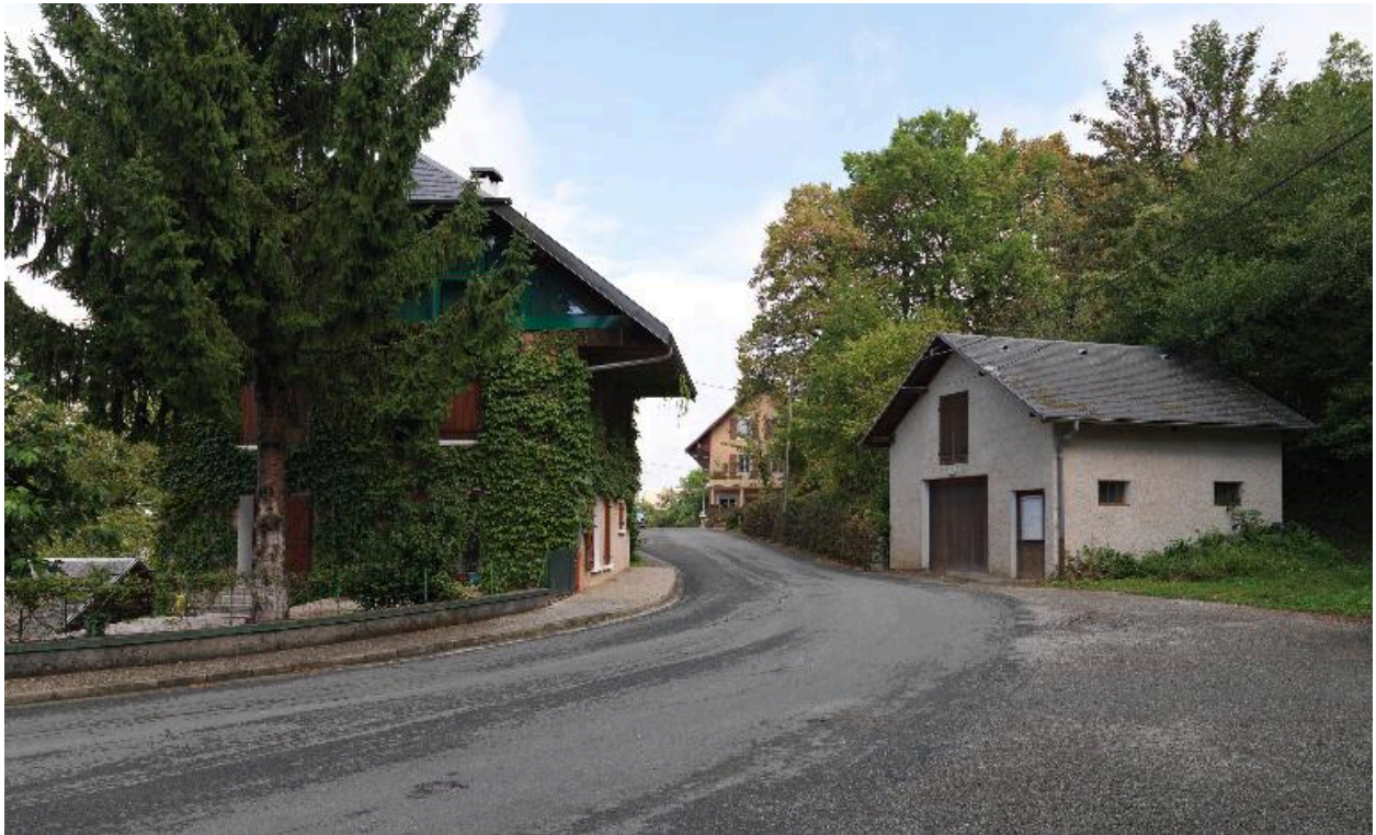
Vue générale intérieure du village vers le nord, RD n° 49. Ancienne fruitière à gauche au premier plan (2014 B3 1191).
