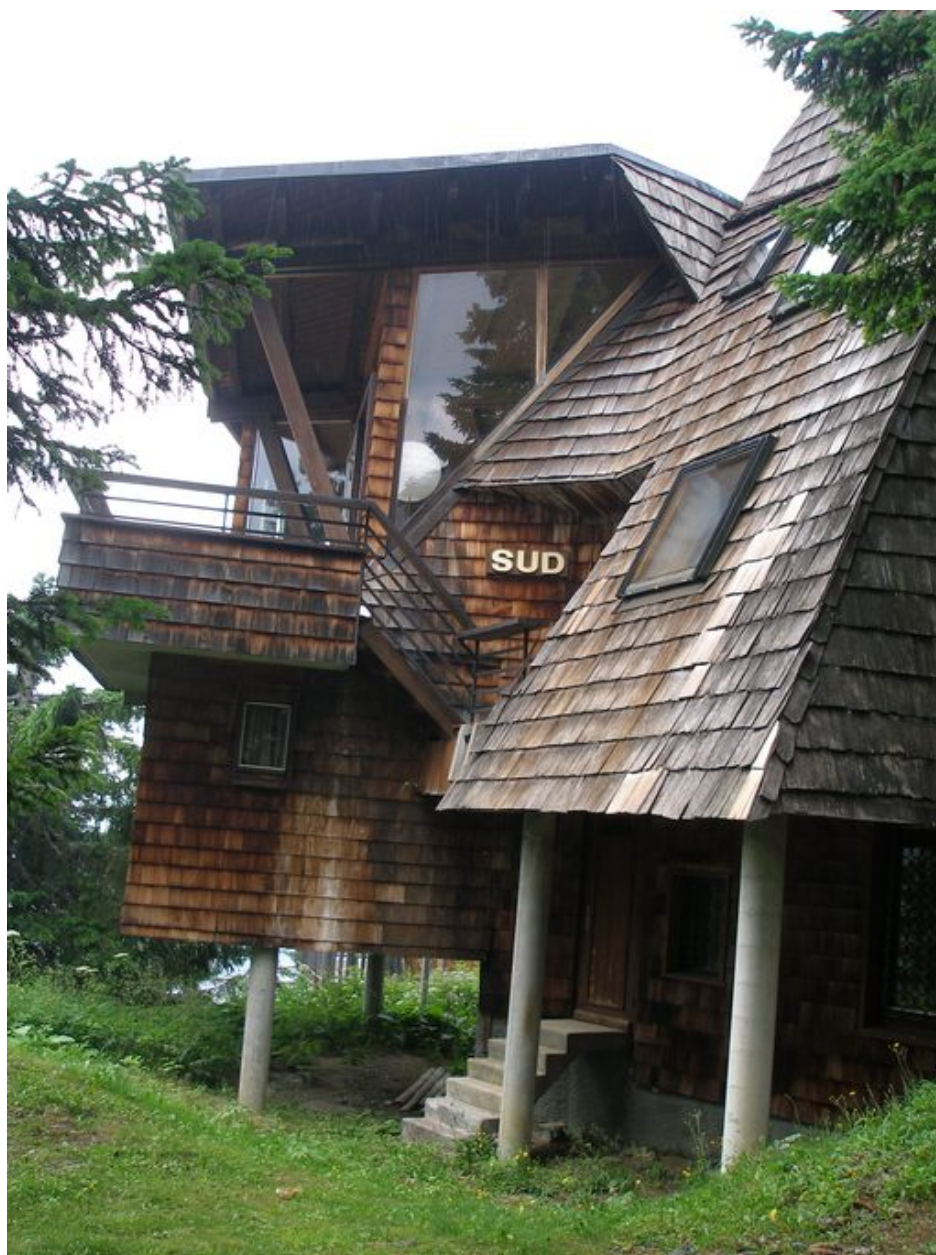
Vue d'ensemble de la façade aval
